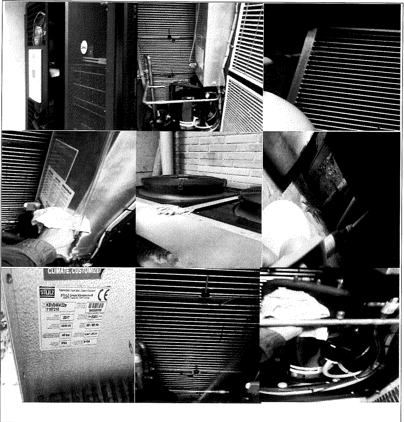
Ilustración 25 Mantenimiento preventivo aire acondicionado.
