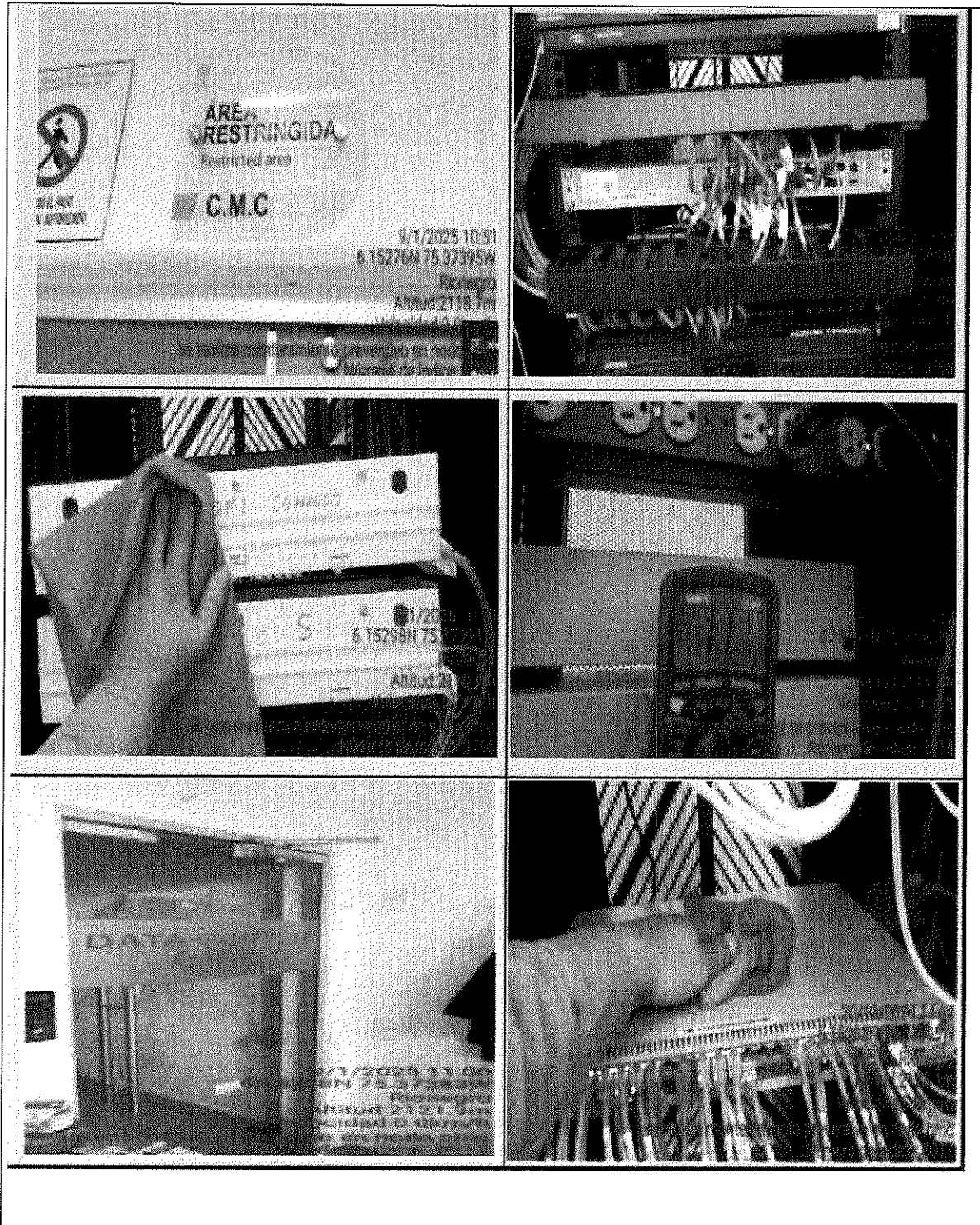
Ilustración 10. Mantenimiento Preventivo CMC.
